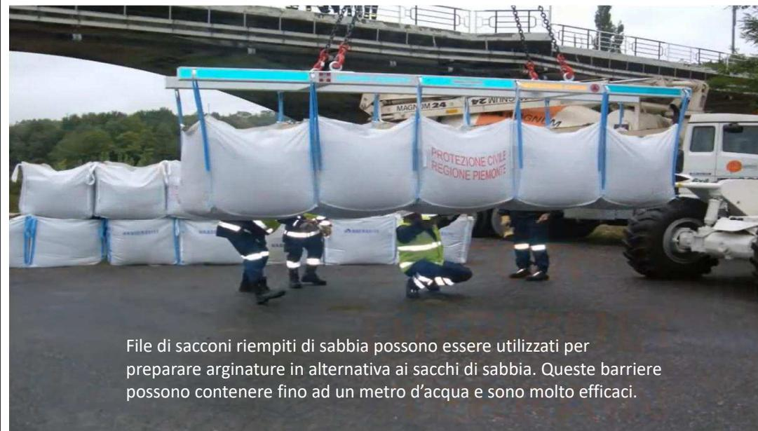
File di sacconi riempiti di sabbia possono essere utilizzati per preparare arginature in alternativa ai sacchi di sabbia. Queste barriere possono contenere fino ad un metro d'acqua e sono molto efficaci.
