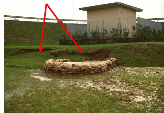
Cedimento dell'argine per sfiancamento dovuto alle infiltrazioni d'acqua e all'inzuppamento
