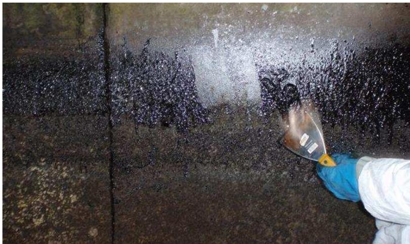
Dopo la rimozione del fango e delle suppellettili dalla casa che ha subito l'inondazione, è necessario lavare pareti e pavimenti con un getto d'acqua, lavarle con acqua pulita e disinfettarle con prodotti a base di cloro.
