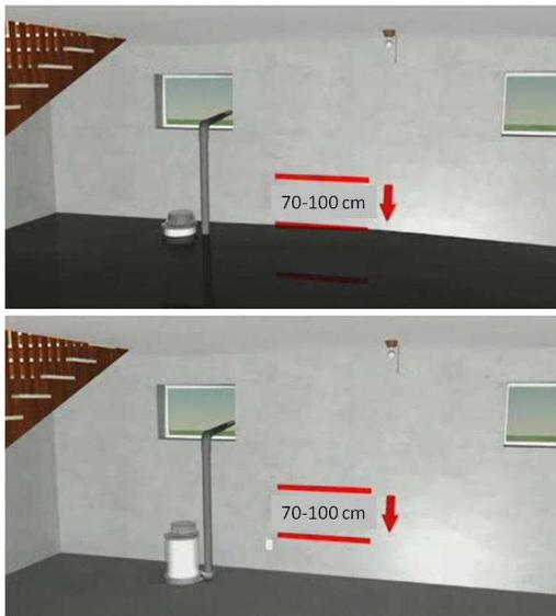
Ridurre il livello dell'acqua di 70-100 cm e verificare ancora se il livello dell'acqua è stabile, diminuisce o aumenta applicando un altro pezzo di nastro adesivo sulla parete al pelo dell'acqua. Se l'acqua è stabile o diminuisce procedere con un'ulteriore operazione di pompaggio. Proseguire con questa tecnica fino a svuotamento completo dell'ambiente.
