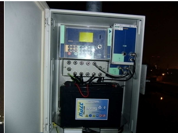
Centralina per la misurazione automatica del livello del fiume Po sul ponte della via Emilia a Piacenza (Funziona a onde radio. Misura ogni 5 minuti durante la piena).
