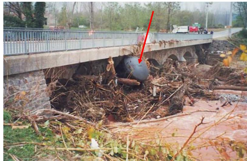
Altri materiali che si possono accumulare sotto un ponte durante un'alluvione.
