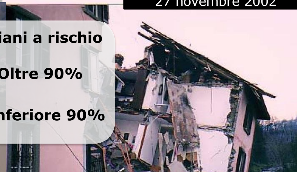
Frana: scivolamento, Infiltrazioni d'acqua sotterranee, Profondità: 15 m, Volume: 30.000 mc, Persone evacuate: 41
